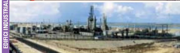
Complesso fertilizzanti di Bahia Blanca, Argentina 2000 (SnamProgetti). Raffineria Grassroots di Midor Ameriya, Alessandria (Egitto) 2001 (Technip Italy).
