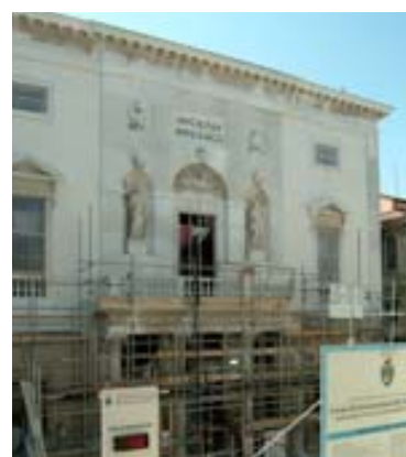
Il recupero della facciata.
