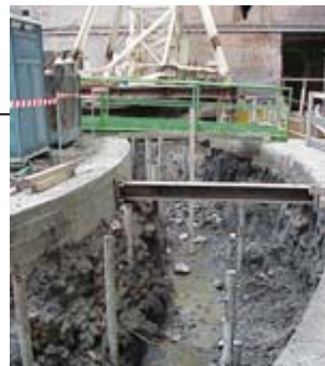
Particolare del cunicolo della cavea durante le opere di ricostruzione.
