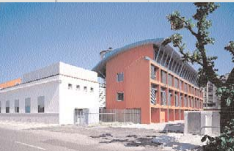
Cittadella della Ricerca e dei Servizi della Scuola S. Anna. Pontedera, Pisa. Ristrutturazione di un capannone ad uso industriale.
