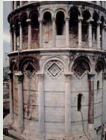
Lavori di recupero della "pelle".
