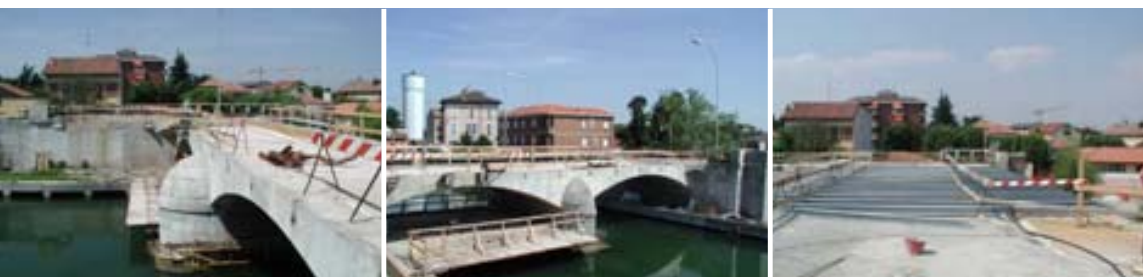
Il Cantiere del Ponte Il recupero delle pile ammalorate. Smantellata la supefetazione del parapetto di ferro, si procede ai lavori. Il rinforzo del manto stradale.
