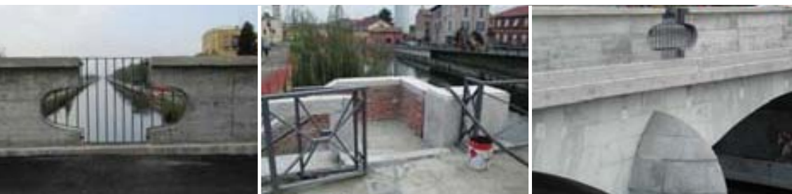
Dettagli La cura dei particolari nel progetto di recupero del ponte.
