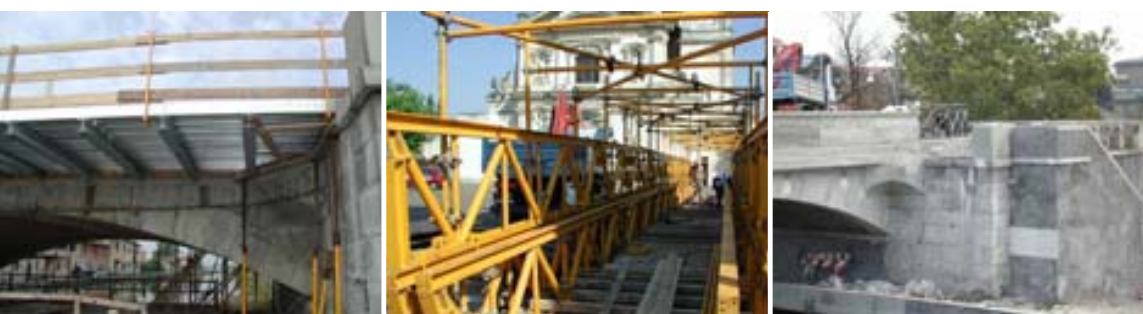
Sotto il ponte. 2 La passerella. La struttura della scala pedonale.
