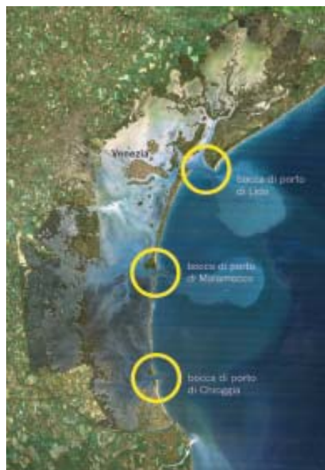
Immagine satellitare della laguna di Venezia in cui sono evidenziate le tre bocche di porto, i varchi del cordone litoraneo che mettono in comunicazione la laguna con il mare Adriatico, dove sono in corso i lavori del Sistema Mose.
