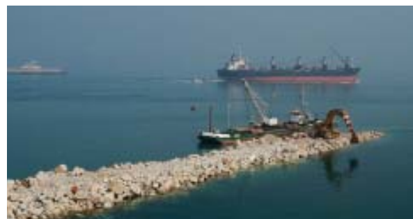
7 Marzo 2004. Il cantiere per la costruzione della scogliera alla bocca di porto di Malamocco, opera complementare del Sistema Mose.
