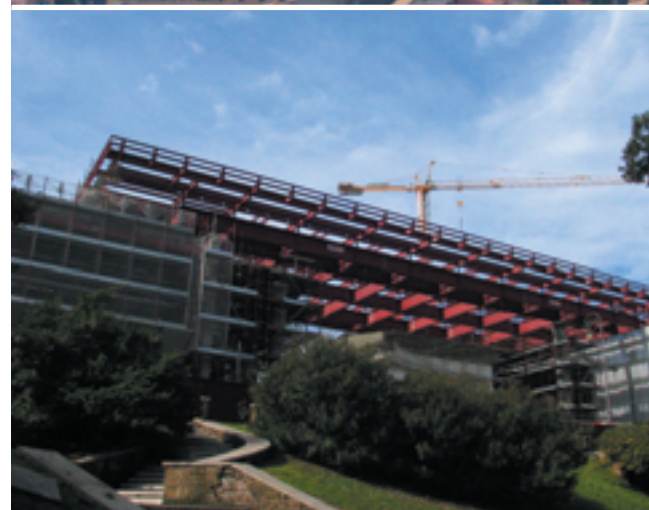
Lavori per l'abbattimento del padiglione Morpurgo e la realizzazione del nuovo Museo.
