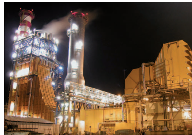
Vista notturna dell'impianto.
