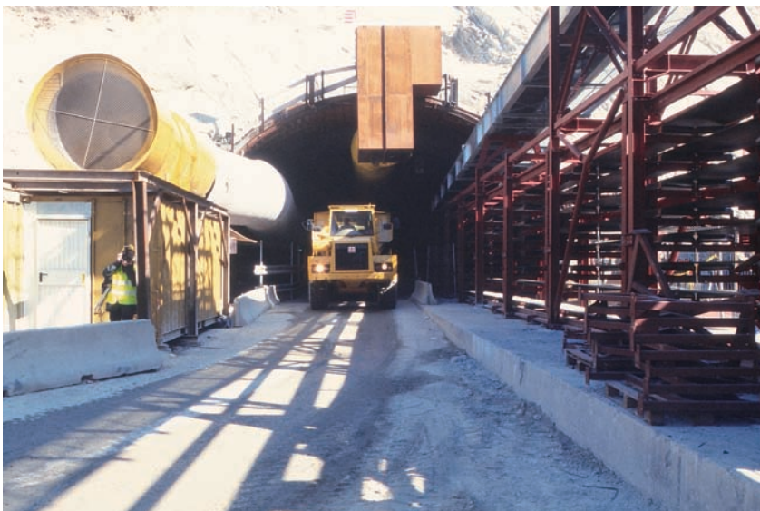
Ingresso del tunnel a Modane.
