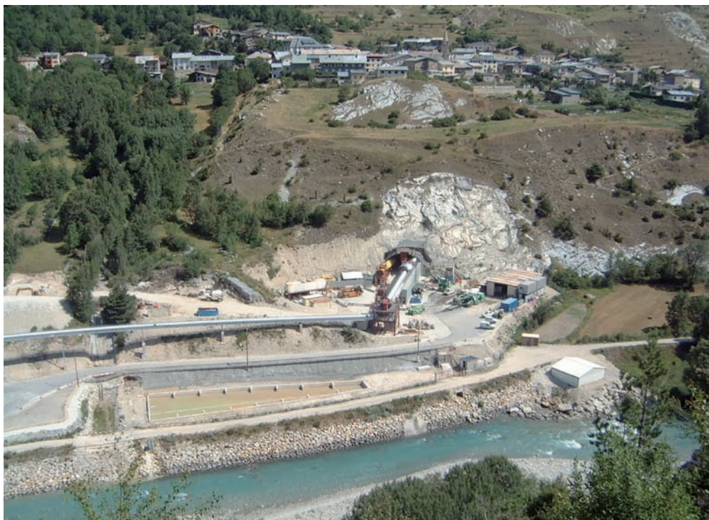
Cantiere della discenderia di Modane.
