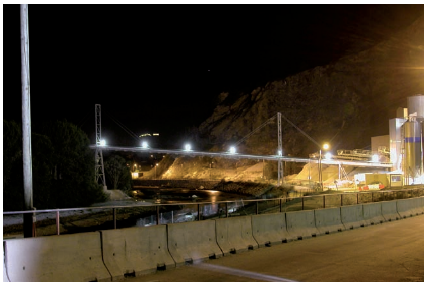
Vista notturna del cantiere a Modane.
