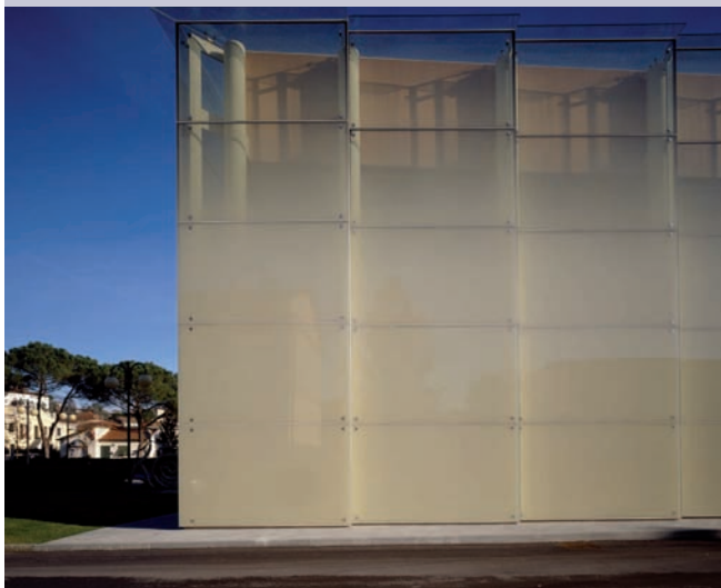
Sopra, vista d'angolo. Si nota la serigrafia che sfuma dal giallo della base alla trasparenza della copertura. A destra, sezione trasversale. Si notano i lucernari di forma conica.
