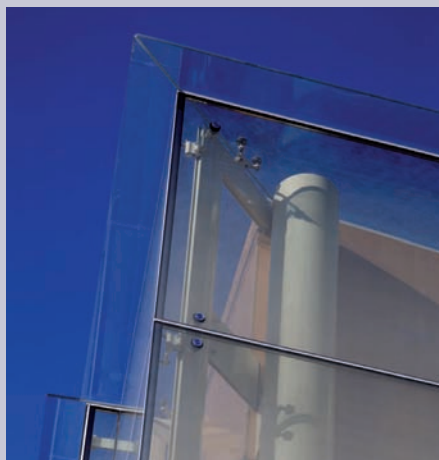
A sinistra, dettaglio d'angolo. Si nota l'attacco fra rivestimento esterno vetrato, pilastro e struttura secondaria in acciaio. A destra, vista frontale dell'ingresso.
