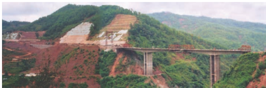
Sviluppo stradale dello Yunnan. Autostrada Yuanjiang Mohei (km 147).
