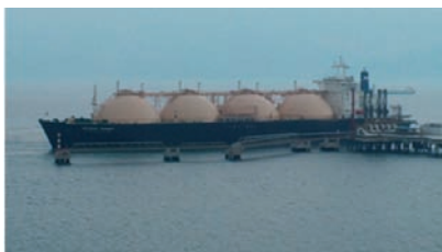
In alto e sotto, LNG Terminal, Guangdong Cina.
