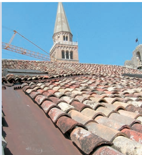
Tetto, vista laterale. I coppi hanno colorazioni differenti a seconda del periodo di fabbricazione.
