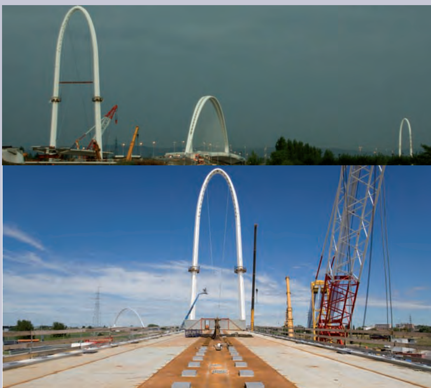
Altri particolari dei lavori in corso.
