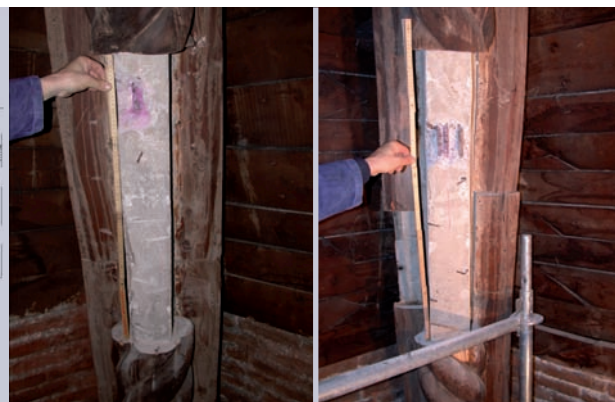
Basilica palladiana. Rilievo ed immagini dello stato attuale degli arconi in calcestruzzo armato della carena.
