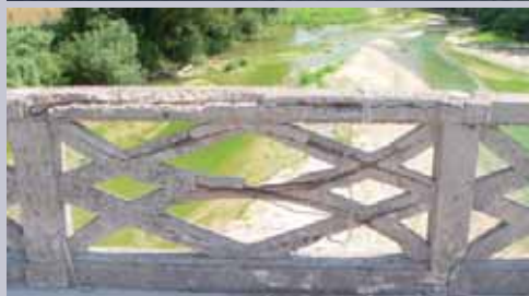
In alto, vista del parapetto del ponte in fase di collaudo (6 settembre 2005).
