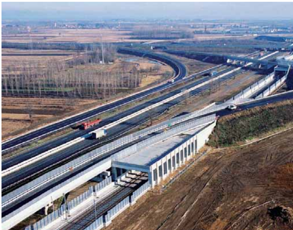
Interferenza linea A.C. intersvincolo A4-A26.
