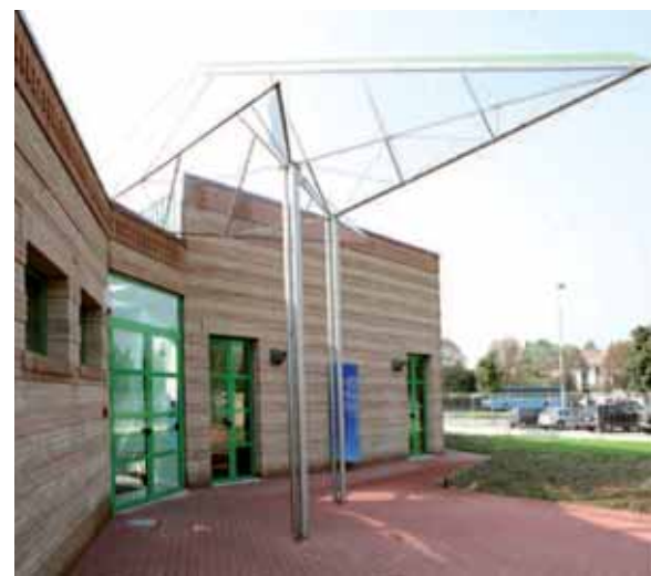
Accesso edificio lato nord.
