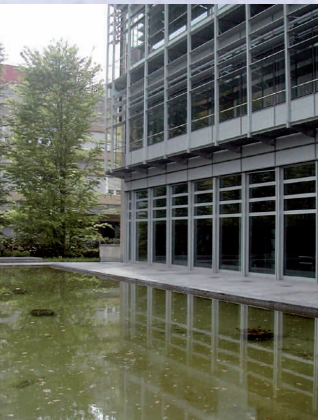
Vasca per fitodepurazione.
