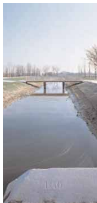
Il ponte che collega il parco al terminal sul limite nord-ovest dell'isola.
