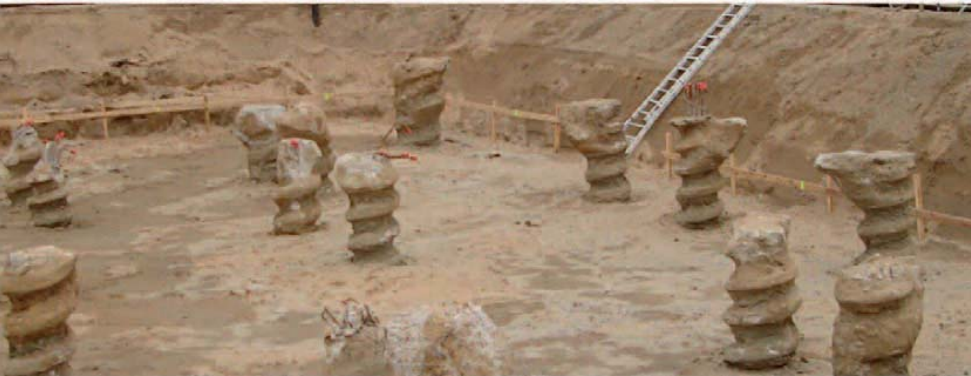
Pali della sottostazione. I pali utilizzati sono del tipo "Screw Piles", realizzati senza asportazione di terreno e senza vibrazioni, mediante l'infissione di una punta ed un tubo camicia con l'azione combinata di una coppia torcente ed una forza assiale.
