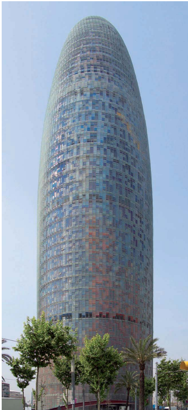
Torre Agbar di Jean Nouvel, a Barcellona.
