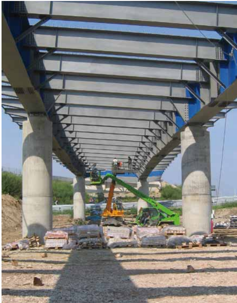
Il progetto ha previsto la realizzazione di due viadotti, uno per ciascuna carreggiata della tangenziale, di lunghezza pari a circa 380 m e larghezza, compresi i marciapiedi laterali, pari a 18 m.
