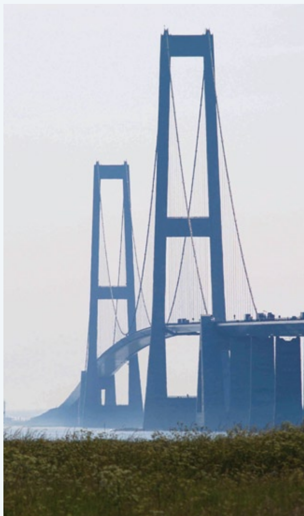
Il ponte Storebelt in Danimarca, congiunge la cittadina di Korsør e la piccola isola di Sprøgo
