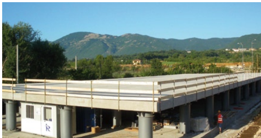
Cantiere a Pagliare Sassa.
