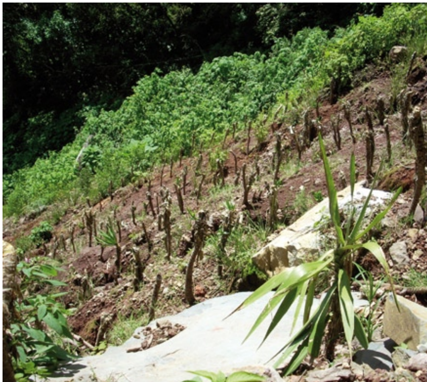
Per una prima fase di messa in sicurezza della frana in quota è stata adottata una tecnica di radicamento di piante autoctone
