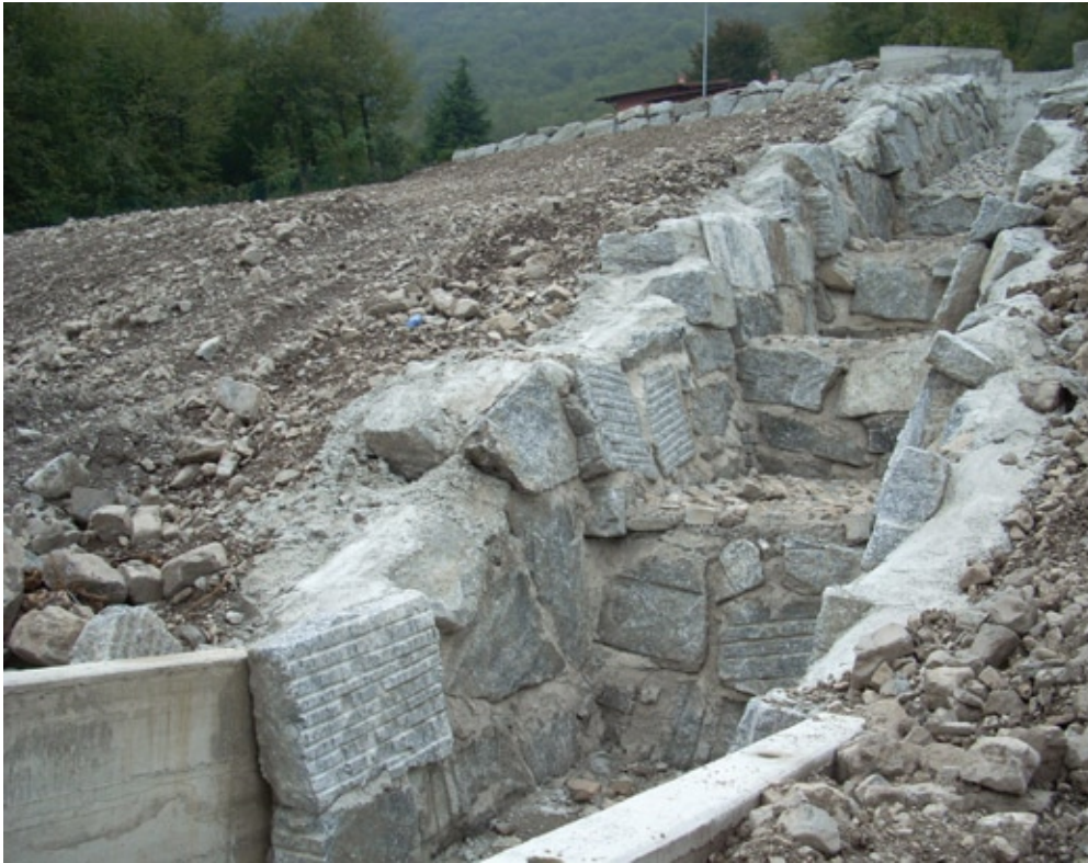
Opere di difesa idraulica dall'erosione dei versanti mediante gradinata di briglie di piccole dimensioni con rivestimenti in pietrame delle sponde
